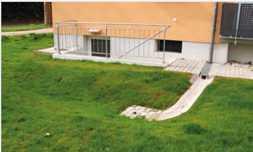
Mulde zur Versickerung von Dachwasser eines Wohnhauses
